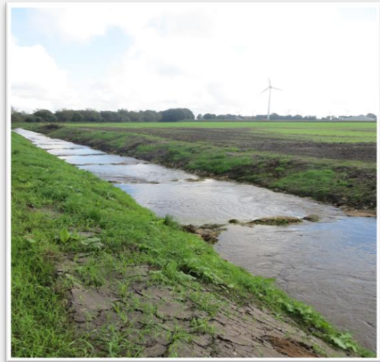
Durchgängige Sohlgleite bei Ohe km 13+670
